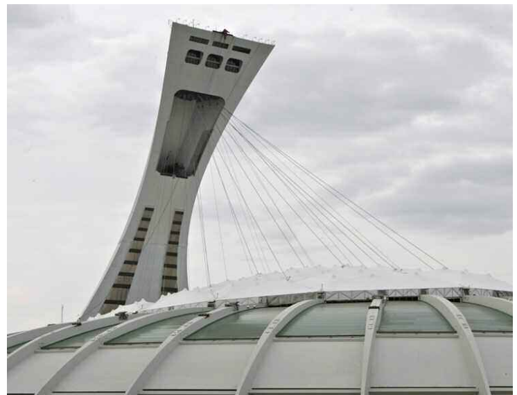
Le stade olympique sera doté d'un nouveau toit. PHOTO PASCAL RATTHE
