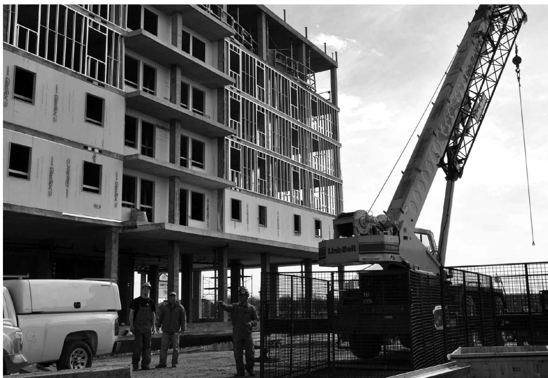
«Sur les chantiers, en raison de la chaleur accablante des derniers jours, tout tourne au ralenti. On est déjà en mode vacances», reconnaît Donald Fortin. PHOTO D'ARCHIVES YVAN TREMBLAY
